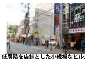
低層階を店舗とした小規模なビルが多い
