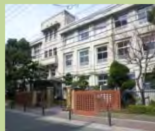
・旧大名小南校舎(昭和4年建築)
