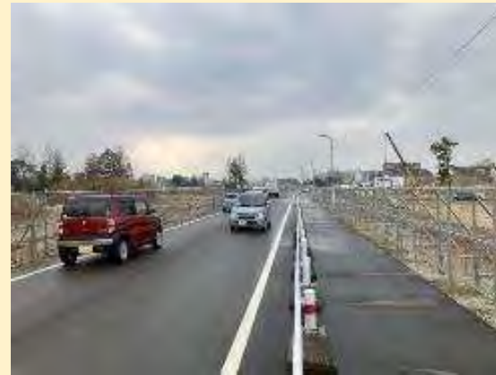
下図①の写真（共用後の仮設道路）
