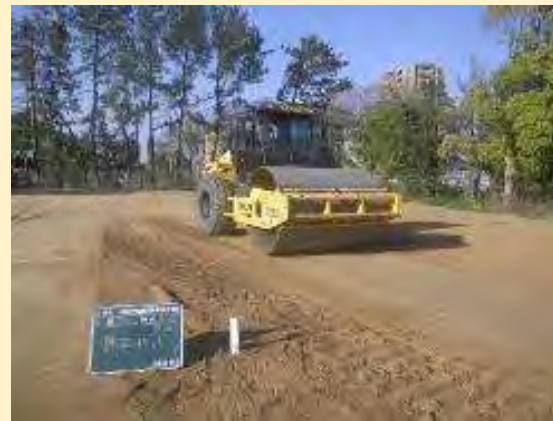
造成工事状況
