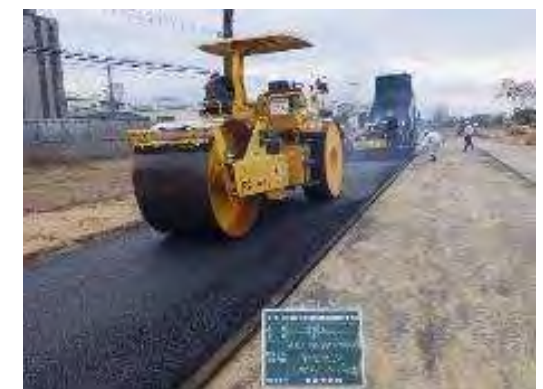
仮設道路（舗装作業）
