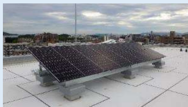
<新築住棟の屋根設置>
