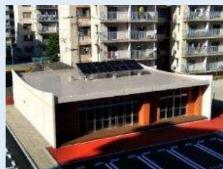
<新築集会所の屋根設置>
