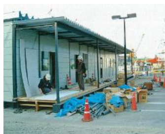
建設型応急住宅の提供
