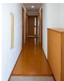
段差なし・手すり
