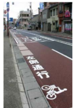
■ 路面表示（ピクトサイン）の例（金沢市）
