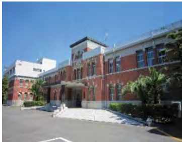
本部第一庁舎 (大正14年建築)
