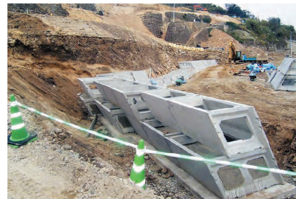
大型ブロック積み工
