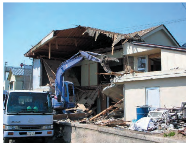
家屋解体着手
