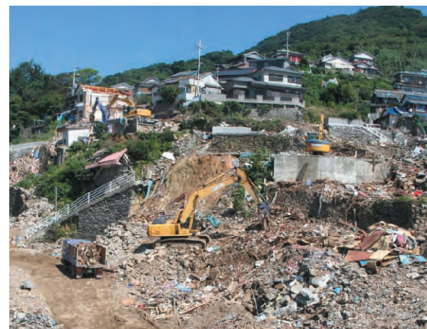
斜面地家屋解体状況
