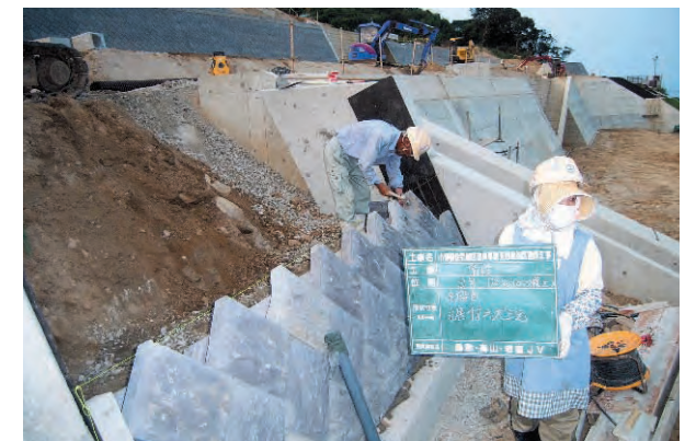
間知ブロック積み工
