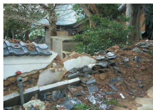
崩れ落ちた白壁
