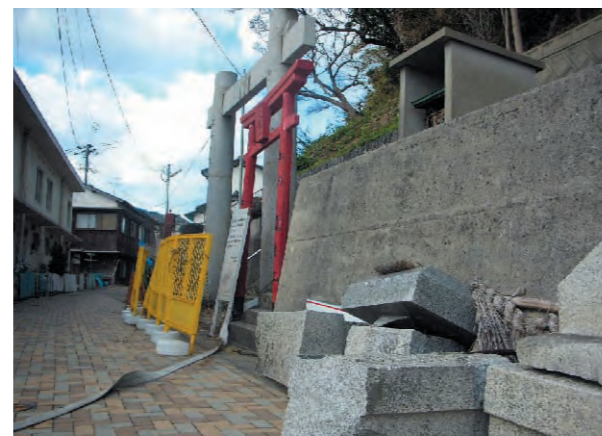
崩落した鳥居
