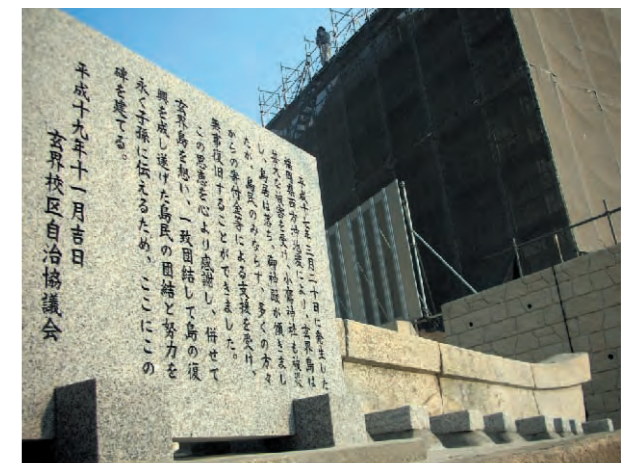
崩落した鳥居は保存
