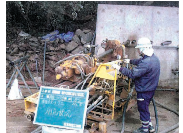
横ボーリング工
