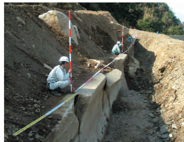
土留壁の設置(大雨による)
