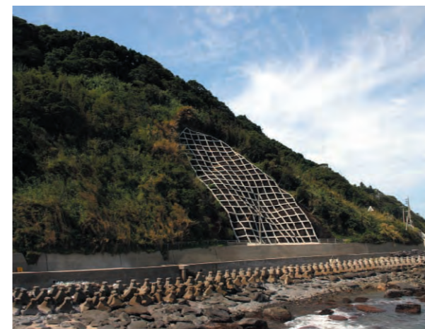
東側崩壊斜面の復旧
