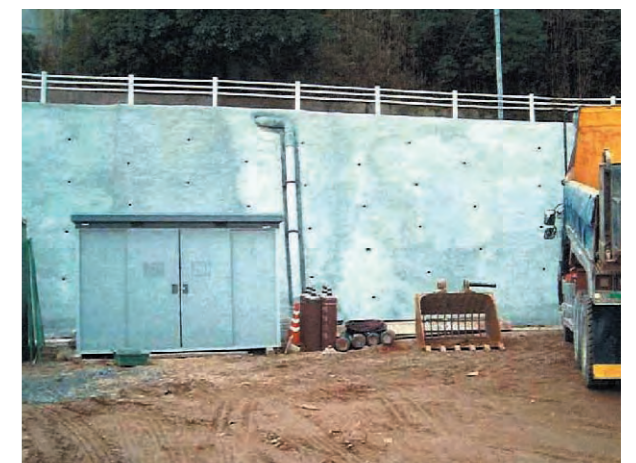
被災した道路擁壁の復旧(西区役所)
