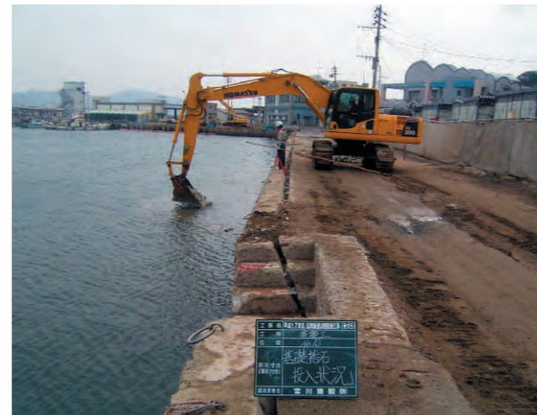
基礎捨石の投入
