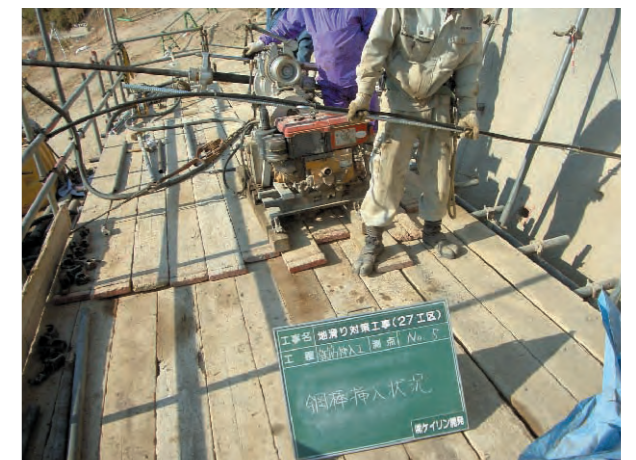
ロックボルト工
