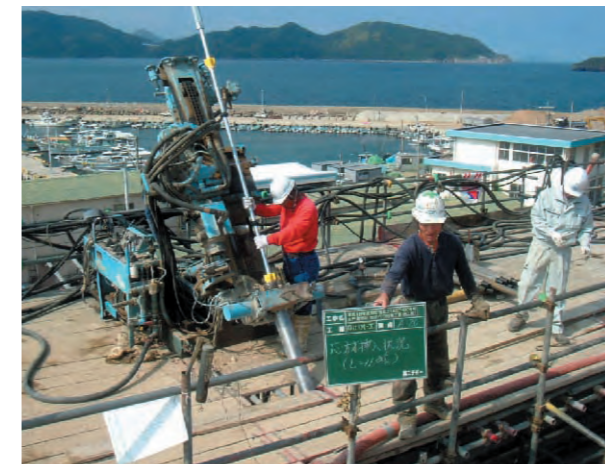
ルートパイル工
