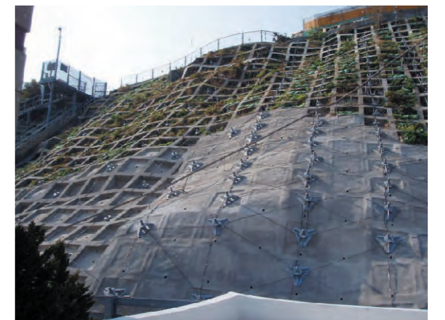
被災した治山施設の復旧
