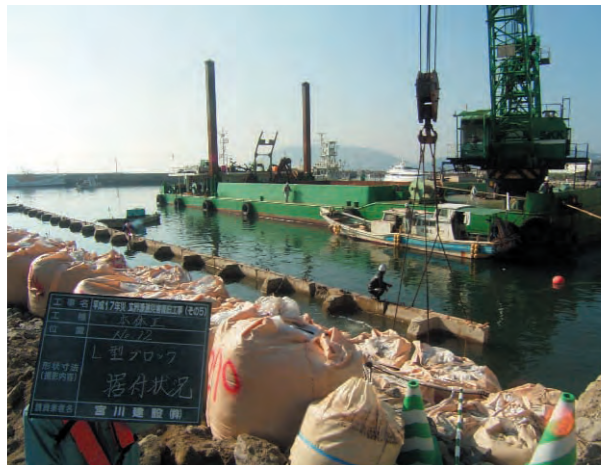
岸壁ブロックの設置
