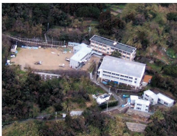
中学校に仮設校舎を建設
