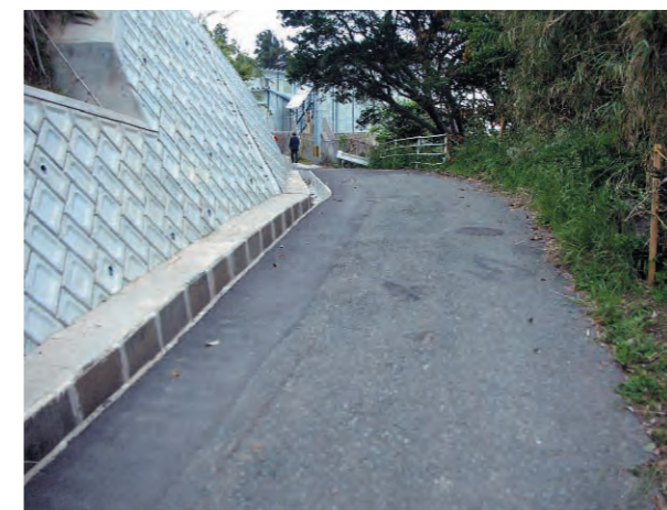
被災した道路の復旧(土木局)
