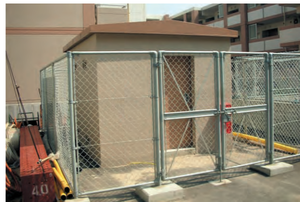
ガスステーション
