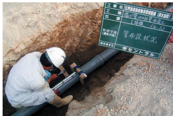
污水管布設状況
