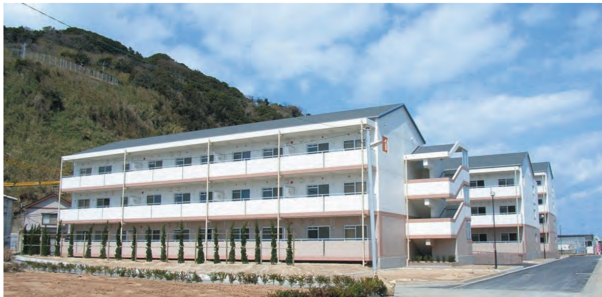
県営住宅完成写真
