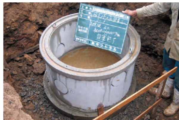
マンホール設置状況
