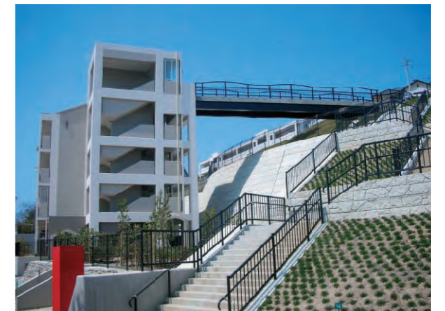
エレベーターにブリッジを連結した上下移動支援施設
