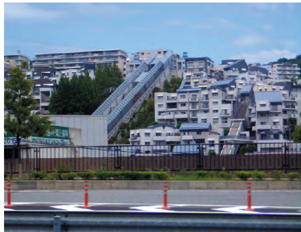
斜面地の集合住宅と斜行エレベーター
