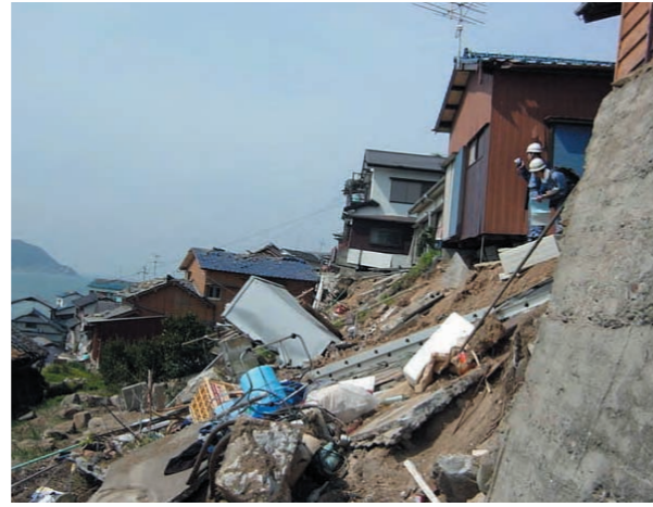
土砂の流れ落ちた法面
