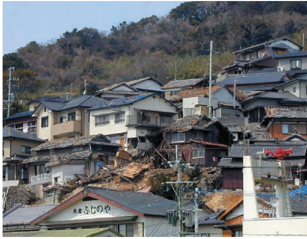
集落部の被害
