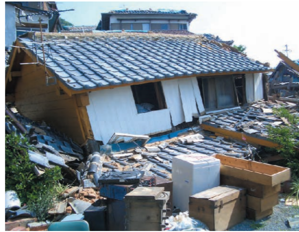
1階が崩れ落ちた家屋
