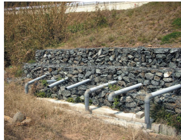
地下水排除工事
