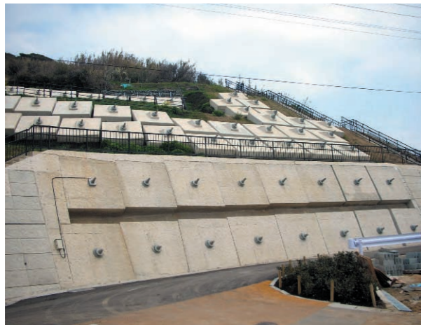
アンカー工事
