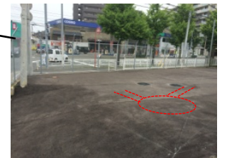
A地区の現況 (地上部はマンホールのみφ600)
