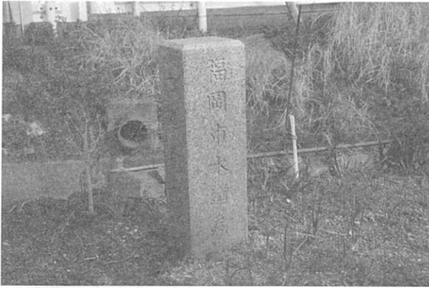
「福岡市水道埋設管」標柱。写真は西側の標柱。川を挟んで反対側にもう1本ある（2013.2.22撮影）
