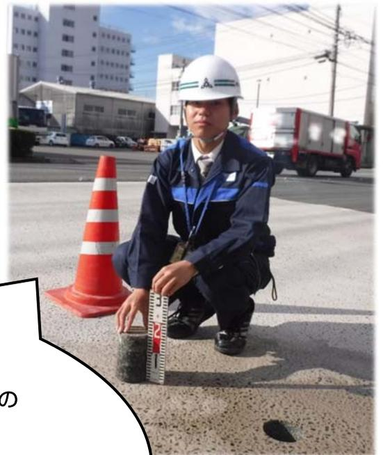
ここの道路は、トラックなど大きい車両が通るのでわだち（タイヤの跡のような凸凹）ができており、通常の舗装でやり替えてもまた同じような状態になるため、半たわみ性舗装という、簡単に言うと、アスファルトとコンクリートが合体したような舗装にしました。これにすることによって、前述のわだちやクラック（ひび割れ）などにも強い舗装が出来上がります！
