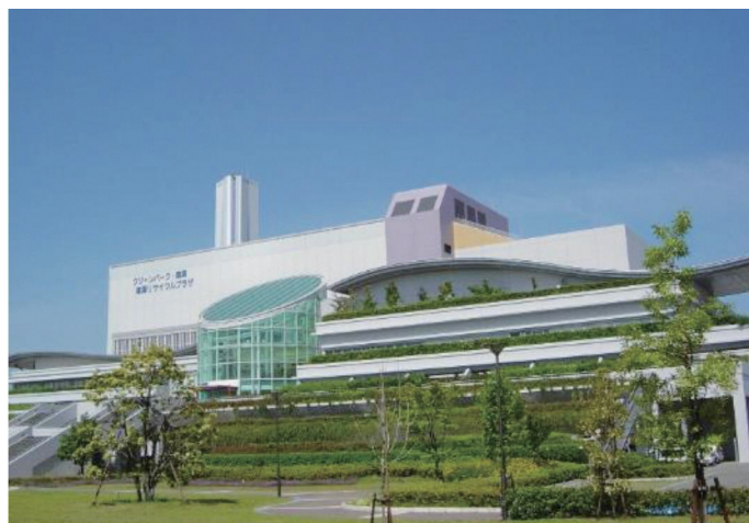
臨海工場(東区箱崎ふ頭にある清掃工場)
