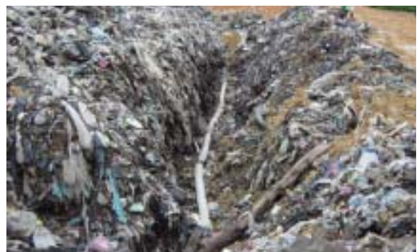
写真 15 ごみ層を掘り上げ浸出水集水管を埋設する改善工事
