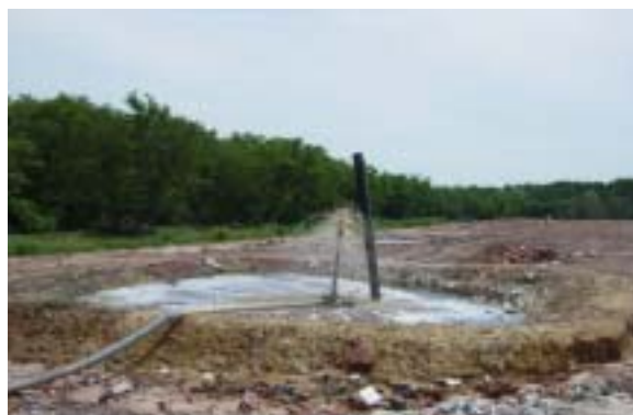
写真 13 浸出水埋立地循環処理施設。返送管は後の方にも伸びている
