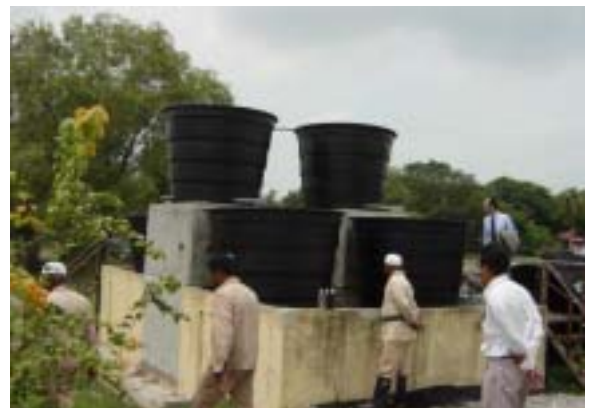
写真8 活性炭やよし繊維を利用した浸出水浄化装置
