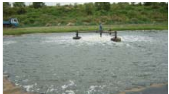
写真 17 浸出水曝気処理池。多くのカエルが泳いでいた。
