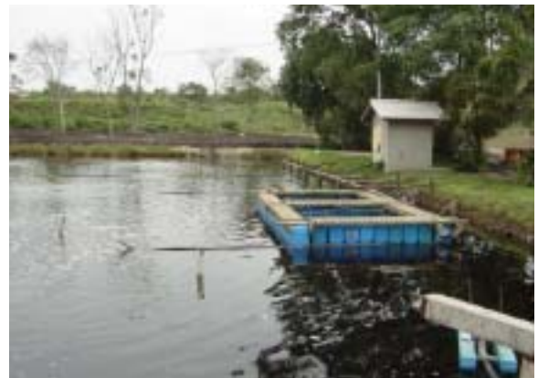
写真7 AmpangJajar埋立場浸出水曝気処理池
