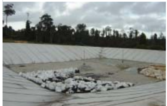
写真 16 工事中の遮水シートを貼った新しい埋立地 産業廃棄物を受け入れる予定
