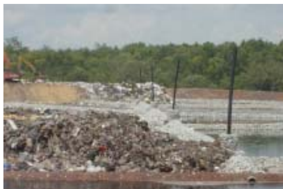
写真 11 Pulau Burung 埋立場の埋立中の様子。ごみが水に浸かっている
