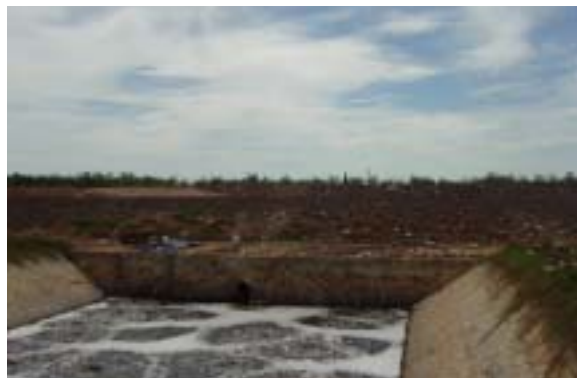
写真 12 埋立終了地区の浸出水曝気処理池
