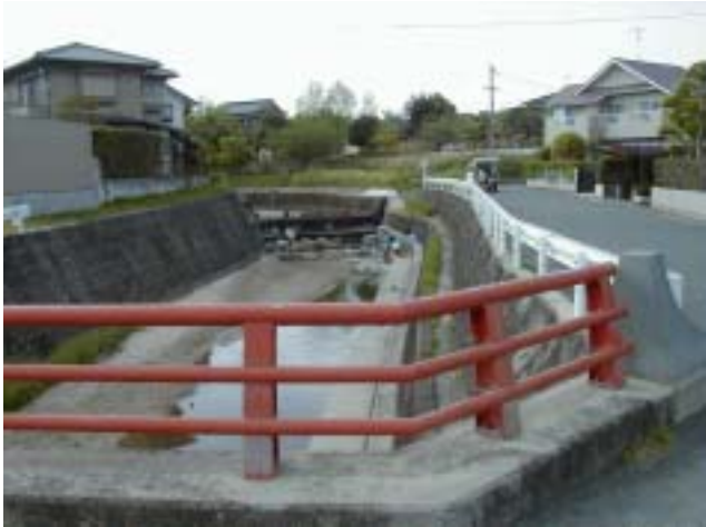
図 2 貴船橋 (柿田橋上流 40m, 貴船橋上流 60m)
