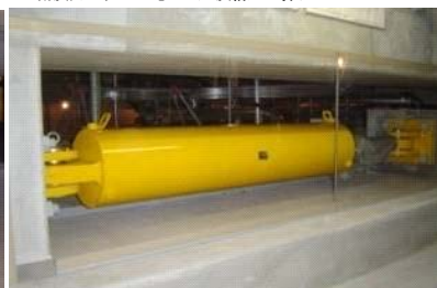
オイルダンパー設置状況
