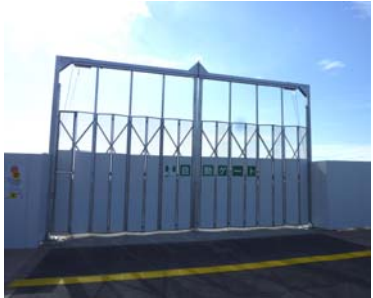
工事車両出入口
