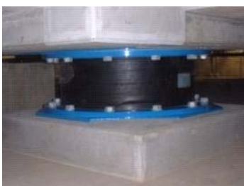
天然ゴム系積層ゴム 設置状況
