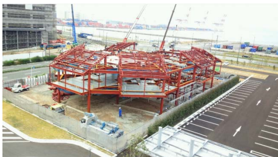
ハウス建設の様子（こども病院より撮影）
