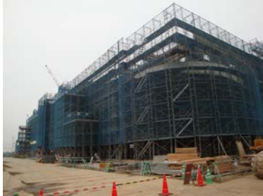
工事の外観（東面）
