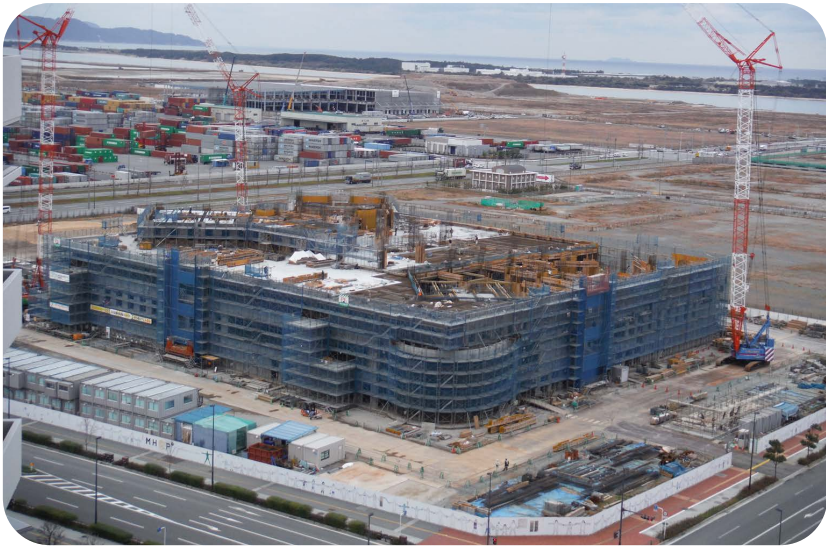
建設現場全景（アイランドタワー15Fより平成25年12月撮影）
