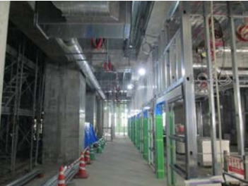
1階の工事の様子
