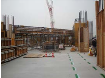
4階屋上庭園の一部)の工事の様子
