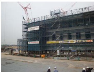
工事の外観（南面）
