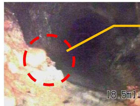
雑排水管の継手部に錆こぶ状のものがあり、進行によっては、水漏れの原因となる可能性がある。
