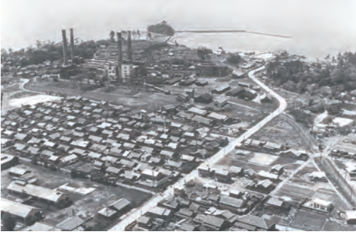
写真右端から発電所に至る引き込み線 (昭和31年当時の写真)
