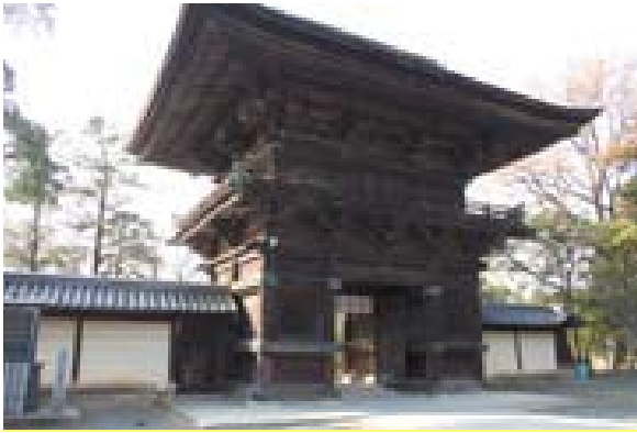
楼門の左右に、ある塀が「筋塀」 帯状の5本の線が入った香椎宮の筋塀
