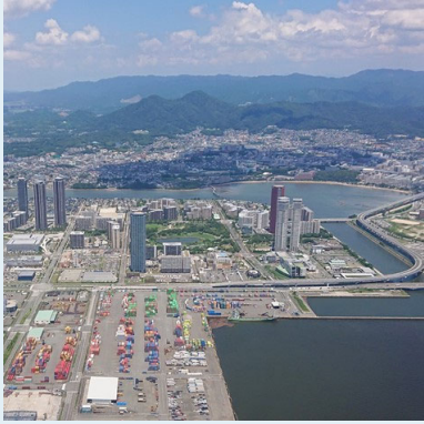
1 アイランドシティ上空 (着陸する飛行機から)
