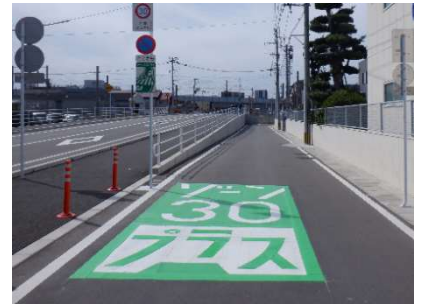
ゾーン 30 プラスの整備
