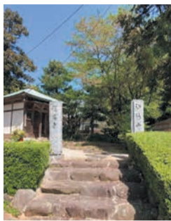
再建された報恩寺
