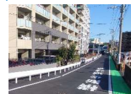
修繕工事完了
