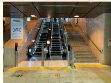
【エスカレーターの増設(博多駅)】
