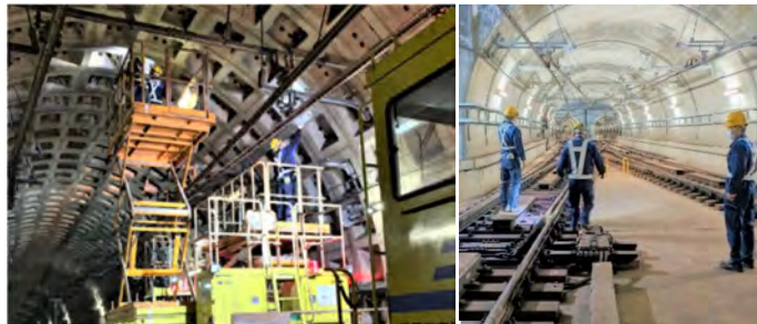
構造物検査（左） トンネル巡視（右）
