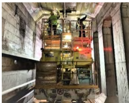
トンネル内点検
