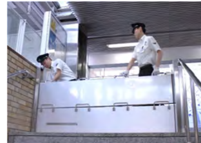
止水板取付の様子
