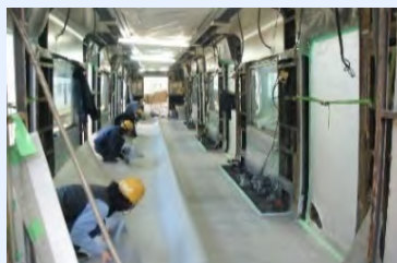
2000系車両大規模改修（内装張替）
