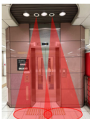
人感センサー付 タッチレス自動運転エレベーター（※センサーはイメージ）
