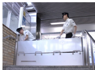
止水板取付の様子
