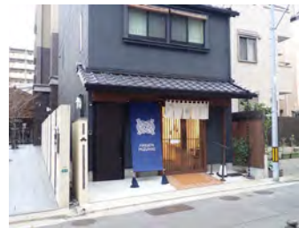
民間建築物の修景助成(上呉服町)
