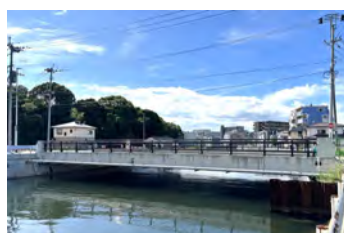
橋梁の耐震化 （西区興徳寺橋）
