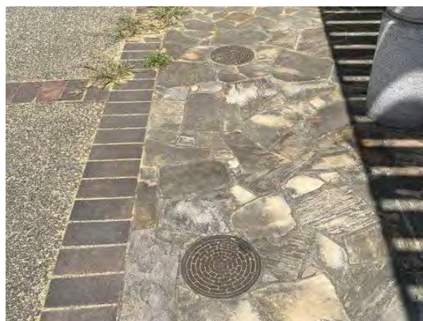
マンホールトイレ（大浜公園）
