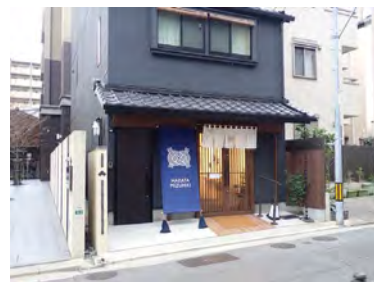
民間建築物の修景助成 （上呉服町）
