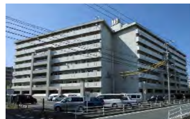
市営住宅の耐震化 (横浜住宅)
