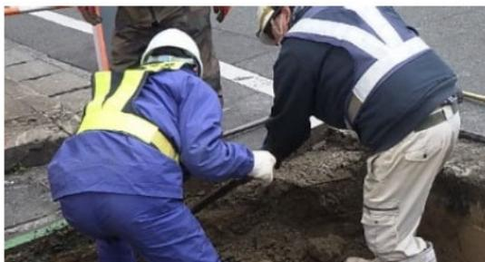
人力掘削による試掘の状況
