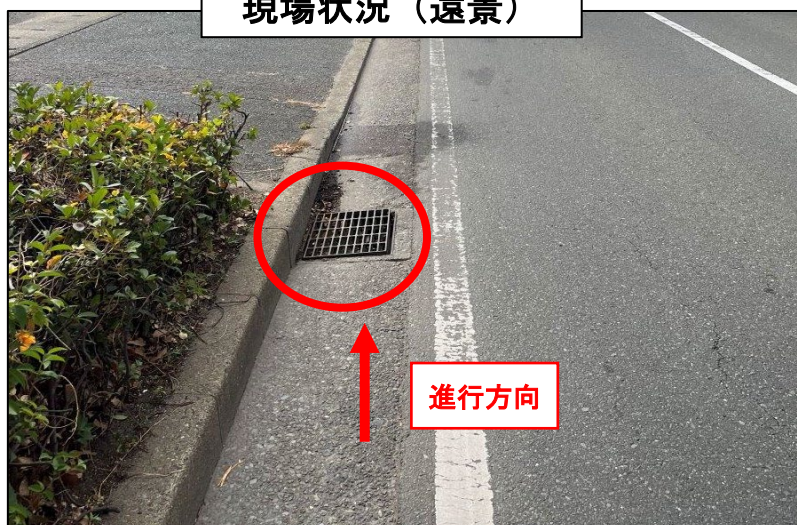
現場状況（遠景）
