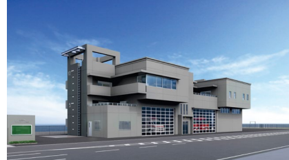
消防出張所 令和9年度 供用開始予定
