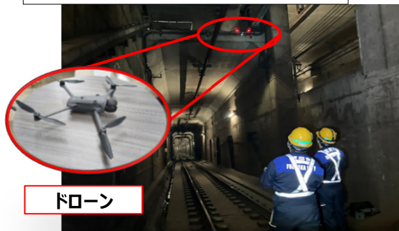
土木構造物の点検にドローン導入
