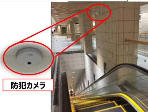
エスカレーター防犯カメラの設置
