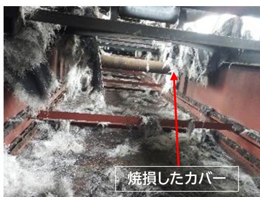
コンベア内部状況
