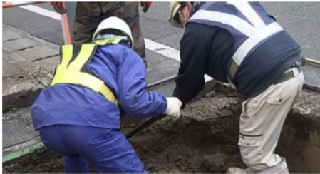
人力掘削による試掘の状況
