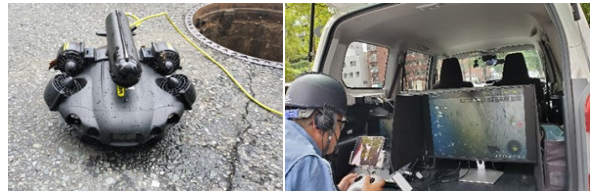
水中ドローンによる管路の点検・調査状況
