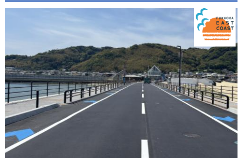
整備事例(海の中道)
