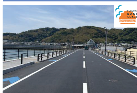
整備事例(海の中道)
