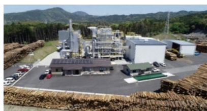
▲ふくおか木質バイオマス発電所
