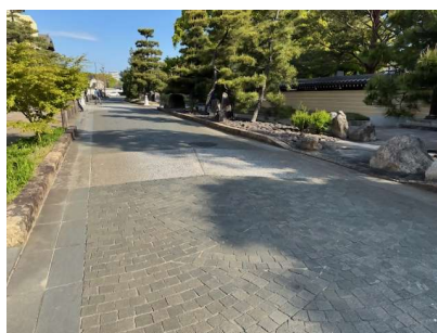
公共空間の景観整備 （御供所地区）
