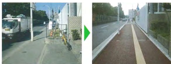
■写真 11 歩道の整備 (歩道拡幅、誘導ブロックの設置)
