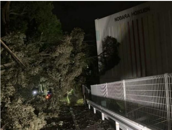
【 事故現場写真 】
