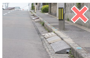
路上に置かれた乗り入れブロック
