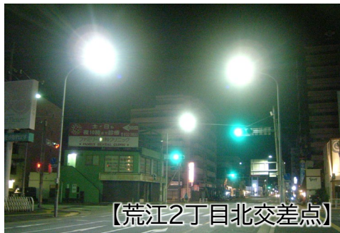
整備事例(道路照明灯のLED化)
