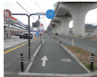
国道 202 号 (西区拾六町)
