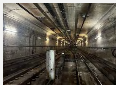
照明のLED化(トンネル)
